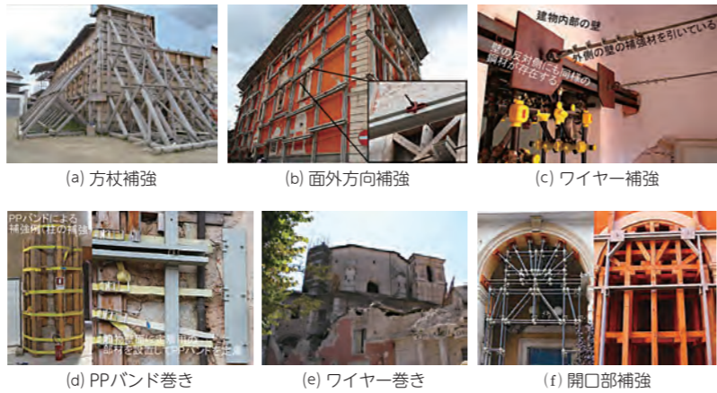
写真4 文化財建築の保護(応急処置)
