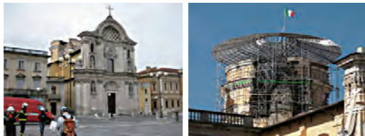
写真3 アニメ・サンテ教会堂：被災直後と応急処置後
