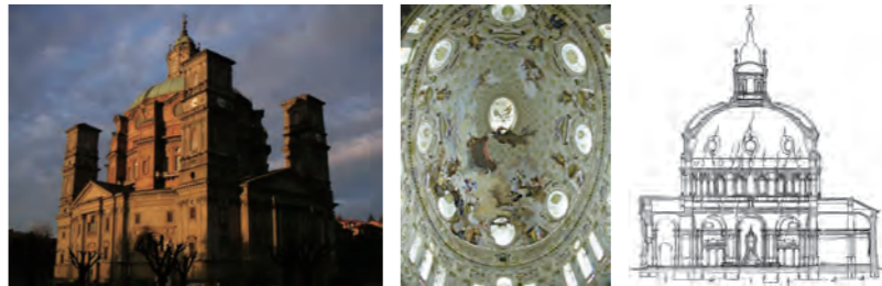
写真1 ヴィコフォルテ教会堂(組積造)：外観、楕円形ドーム、ひび割れ図 (Garro)
