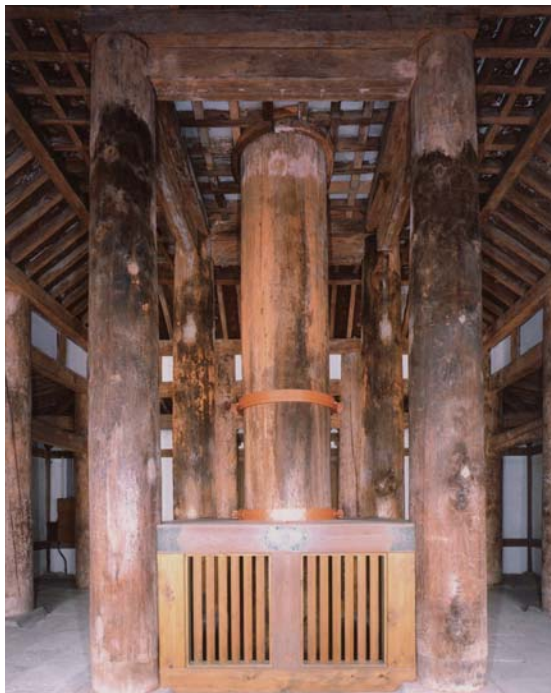
内部が空洞化している心柱(中央)
