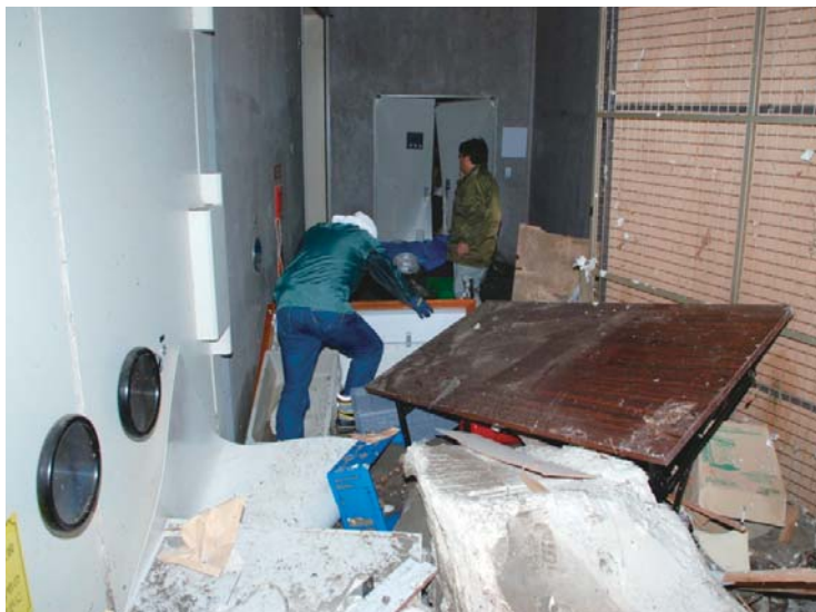
同館内の被災状況（1階収蔵庫前の通路）
