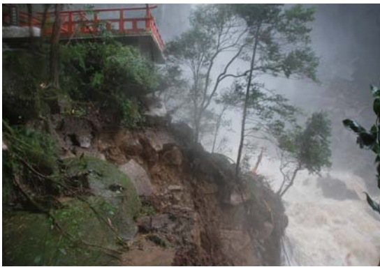
別宮拝所舞台へ向かう参道右側(滝側)が大木ごと根刮ぎ崩落する
