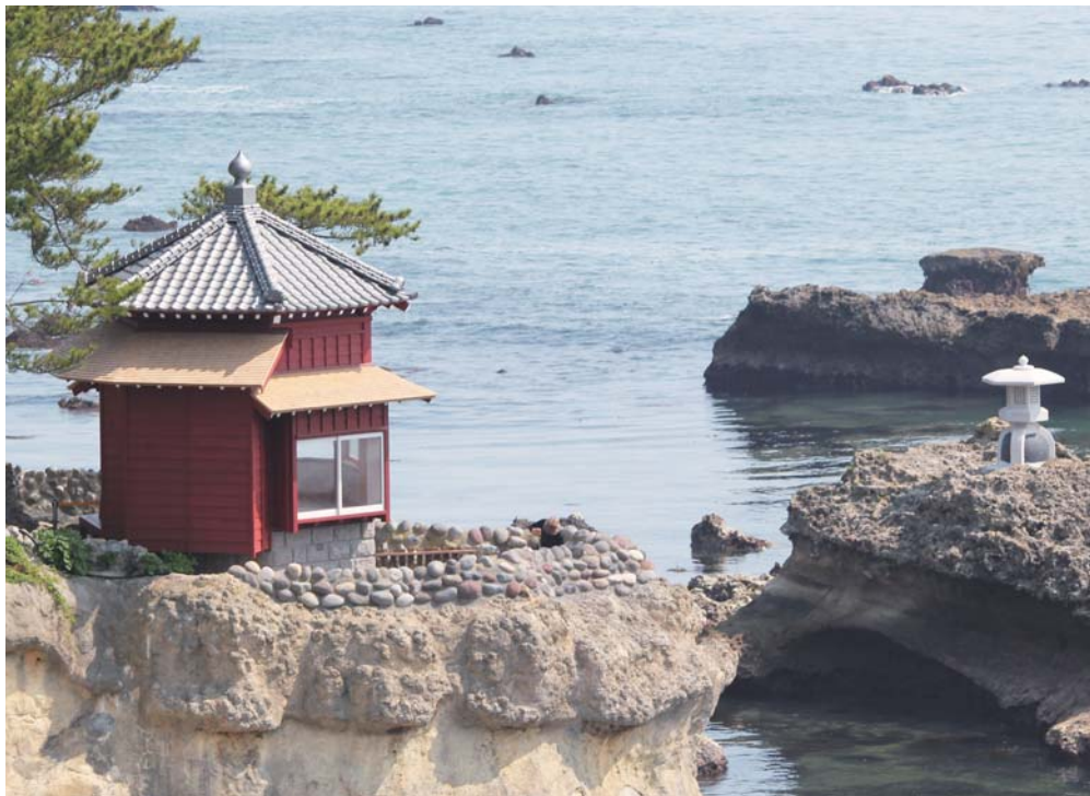
再建なった六角堂
