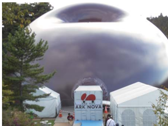
特殊なポリエチレン製の被膜を用いて作られた異次元感覚の移動コンサートホール
