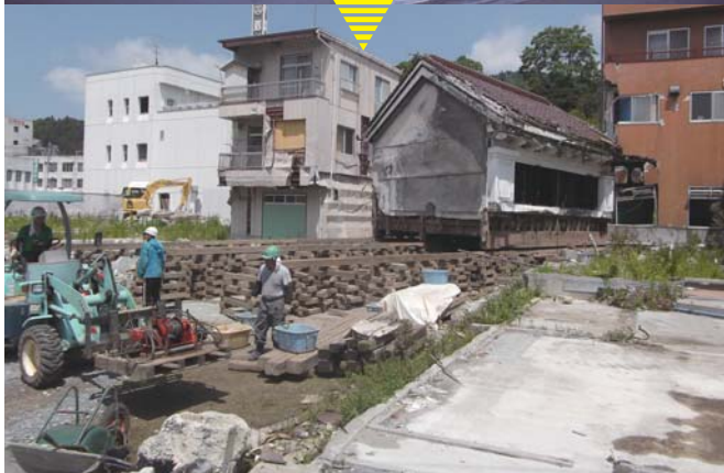
角星店舗の曳き家作業
