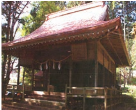
修復された「八幡神社拝殿屋根」 (愛媛県久万高原町)
