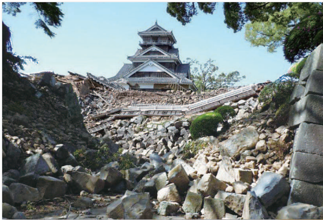
大きく崩落した熊本城の石垣（熊本市提供）
