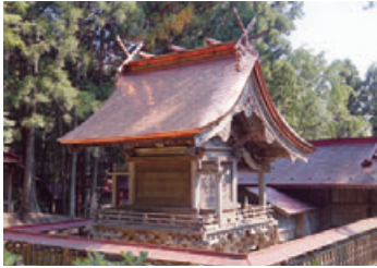
福島県・八幡神社 八幡神社本殿建造物保存修理事業
