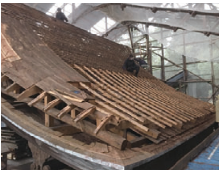
現在、進行中の工事の様
