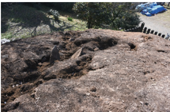
被災後の井寺古墳（墳丘亀裂から内部の石材が露出） 嘉島町教育委員会提供
