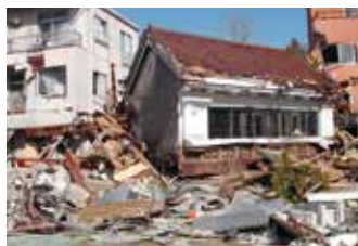
角星店舗被災直後
