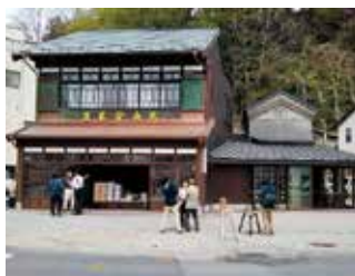
完成した武山米店
