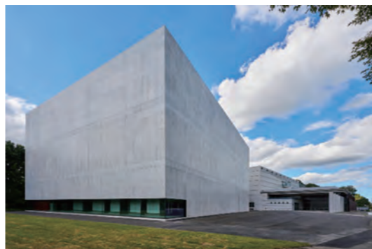
取手収蔵棟 2024竣工 (奥の建物が取手館)
