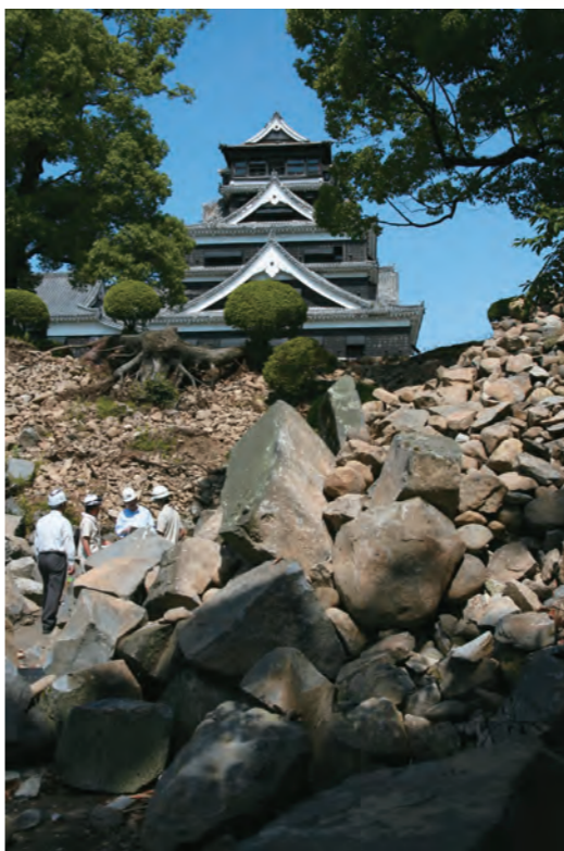
震災被害を受けた熊本城跡。平成28年（2016）撮影
